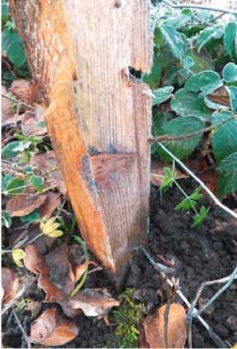
Abbildung 3: Bodenpfahl – insbesondere bei Hängezäunen erforderlich.
