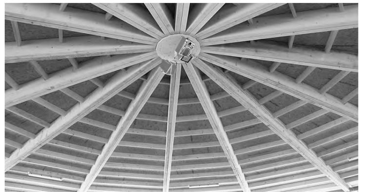
Das Dach der neuen Reithalle basiert auf der Konstruktion eines Rades
