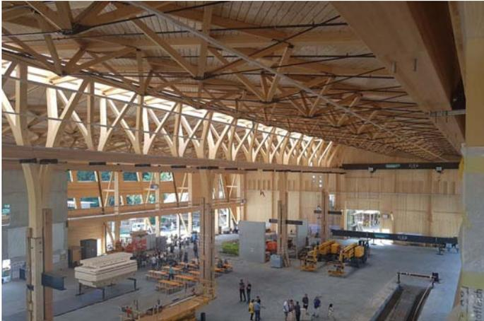
Werkhalle eines Gewerbebetriebes in Saland ZH mit Kranbahn aus Stabbuche von Fagus. (Bild Fagus Suisse SA)
