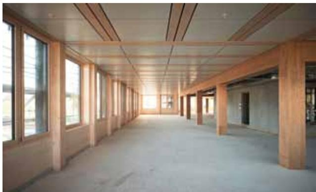
Blick in das Innere des ersten Holz-Hochhauses in Risch. Nicht nur die Konstruktion besteht zu einem wesentlichen Teil aus Holz, sondern auch die inneren Oberflächen lassen das Material in vielerlei Art sichtbar werden. Das Zusammenspiel von Holz und Beton prägt den Charakter der Räume.
